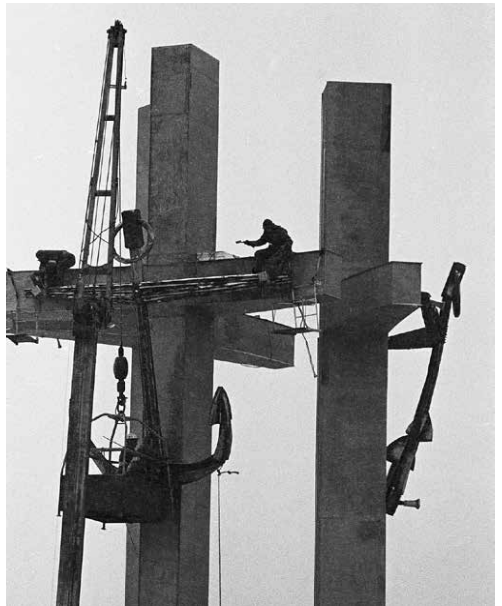
Budowa pomnika Poległych Stocznioowców 1970, mocowanie kotwic na ramionach krzyży, Gdańsk, grudzień 1980
